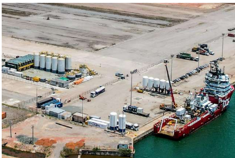
Figura 6 - Vista aérea de planta de fluidos da Baker Hughes na Base Dome
