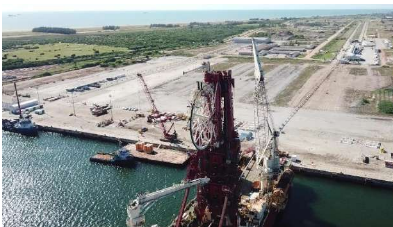
Figura 2 - Início das operações da spoolbase da TechnipFMC na base da Dome
