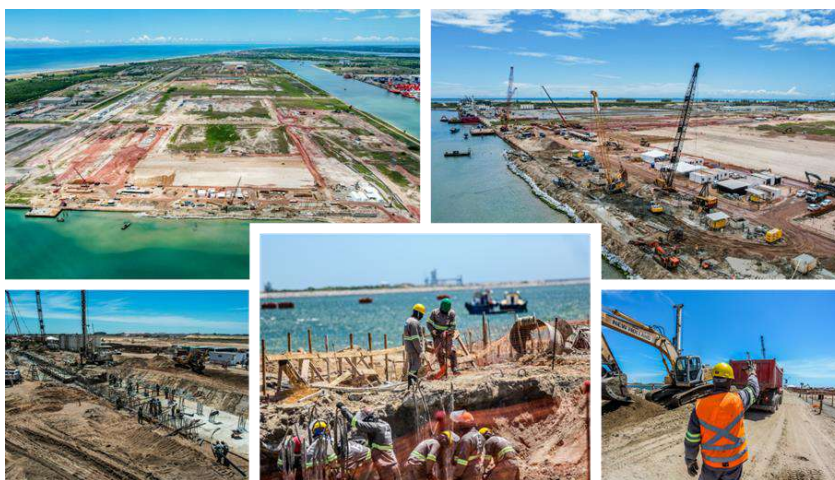
Figura 5 - Obras de construção da base da Aliseo na OSX
