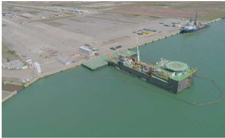
Figura 3 - Início das operações da McDermott na base da Dome
