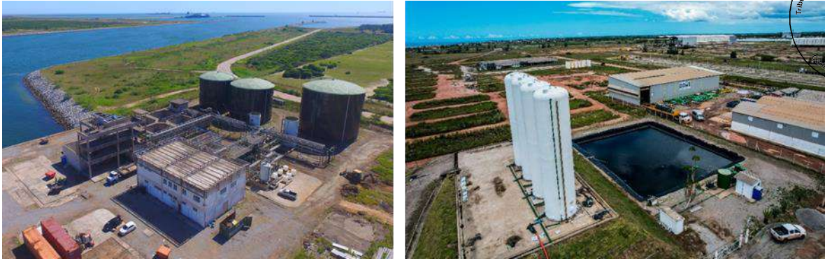
Figura 9 - Estação ambiental de tratamento e logística de resíduos offshore, água e lama
