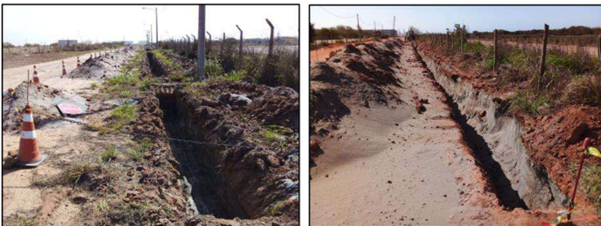
Figura 8 - Implantação de rede de distribuição de água industrial e potável
