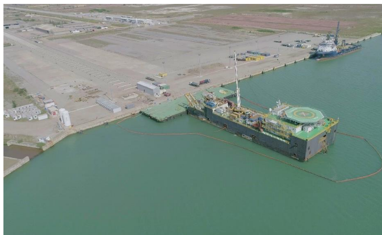
Figura 3 - Início da operação da Spoolbase McDermott na base Dome.
