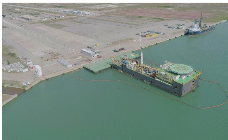
Figura 3 - Início da operação da spoolbase da McDermott na base Dome
