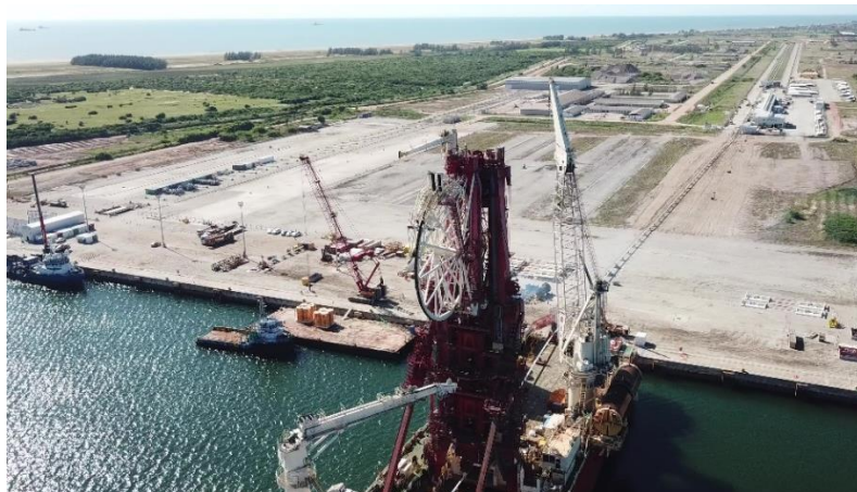
Figura 2 - Início da operação da spoolbase da TechnipFMC na base Dome
