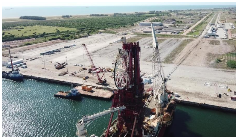
Figura 2 - Início da operação da Spoolbase TechnipFMC na base Dome.
